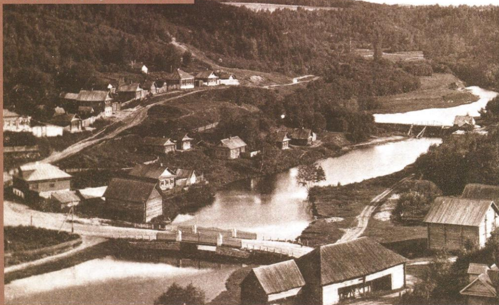
Каскад мельниц на р. Шохонке, 1910 г.
