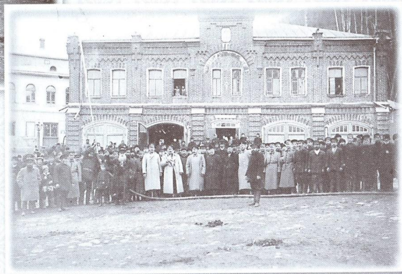
Освидетельствование водопровода в Плесе. 1909 г. Фото В.И. Кузнецова.
