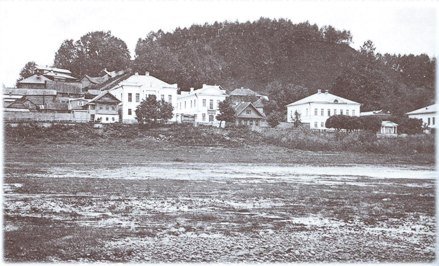
Набережная Пlesa от дома Новожилова до дома Введенской. 1910-е гг.
