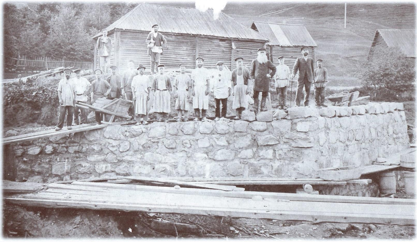
Строительство каменного моста через р. Шохонку в Плесе. 1908 г. Фото В.И. Кузнецова.
