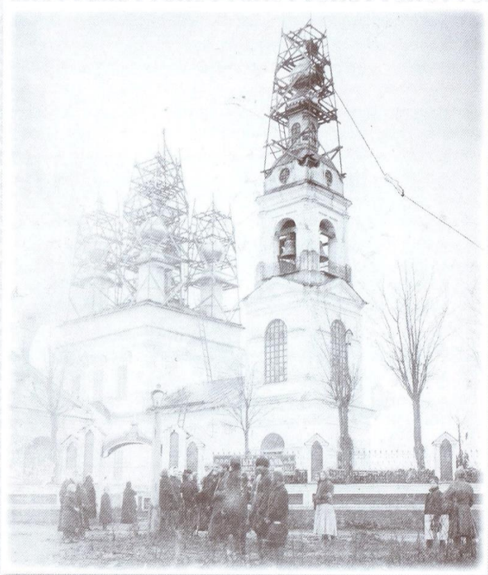
Ремонт Троицкой церкви. 1909 г. Фото В.И. Кузнецова.
