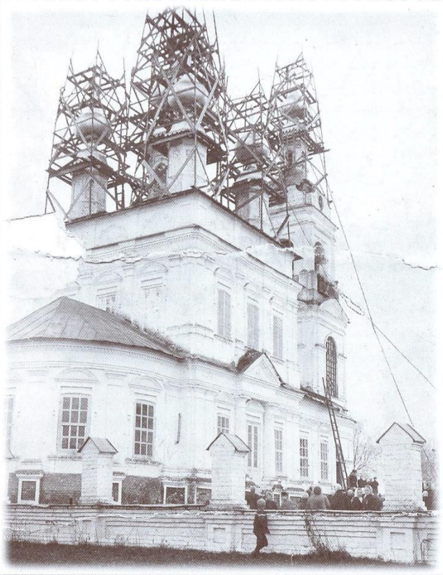
Троицкая церковь в лесах. 1909 г. Фото В.И. Кузнецова.
