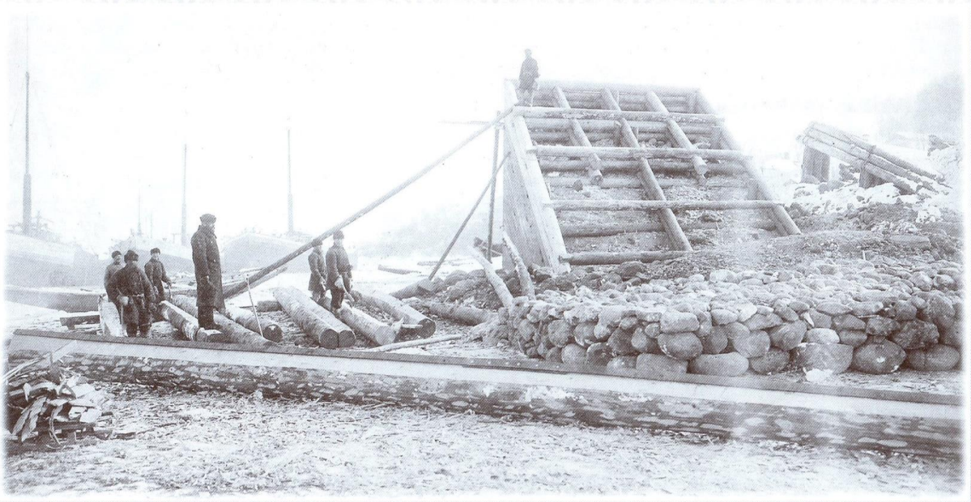
Работы по строительству верхних ледорезов. 1907-1908 гг.
